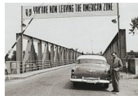
1964: Wechsberg an der Glienicker Brücke
